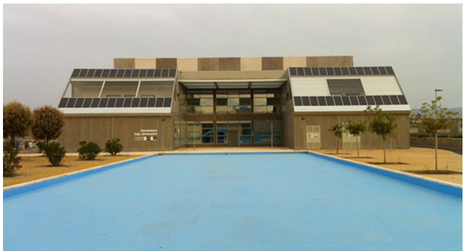
Vista de la instalación desde la lámina de agua situada delante de la fachada.
